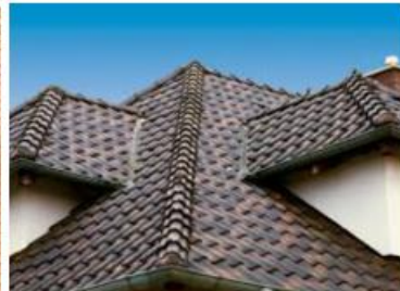
Şəkil 3. Kərəmit dam örtüyü
