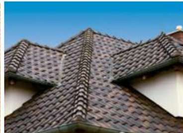
Şəkil 3. Kərəmit dam örtüyü
